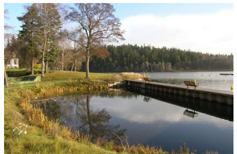
Dagvattendamm i Kungsängen som har försetts med en läns vid utloppet för avskiljning av olja.
