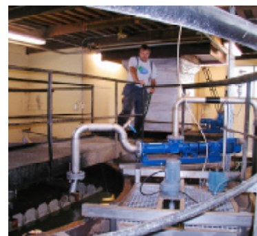
Ombyggnation av Vadsbro reningverk, Flens kommun
