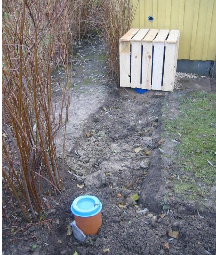
Ett grunt dike grävs på lämpligt ställe.
