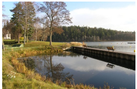
Dagvattendamm i Kungsängen som har försatts med en läns vid utloppet för avskiljning av olja.
